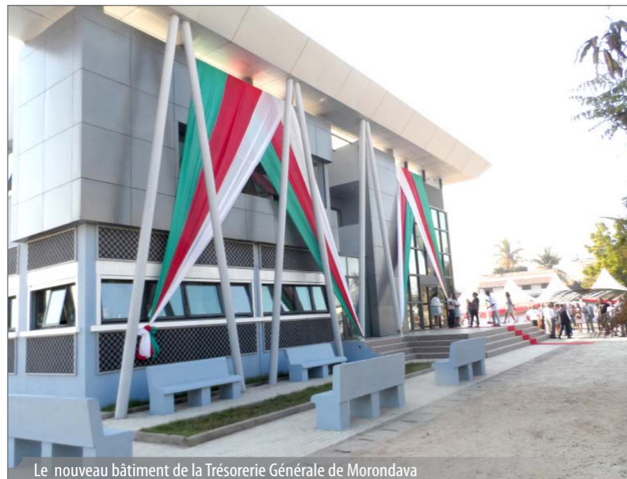
Le nouveau bâtiment de la Trésorerie Générale de Morondava
